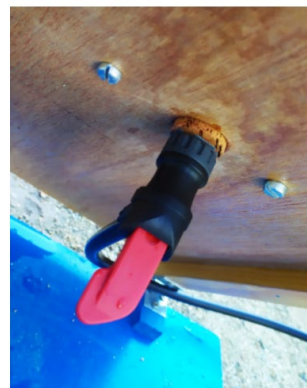
Detall de la vàlvula de la bomba connectada a la rosca del suro
